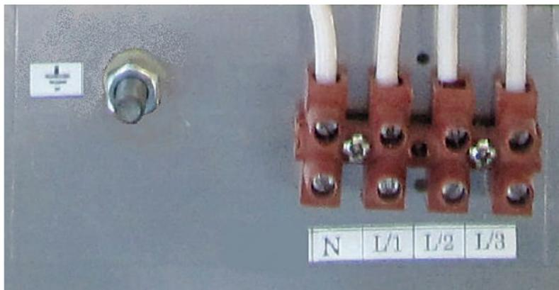
**Рис. 2** Клеммная колодка и приварной контакт заземления ЭН
